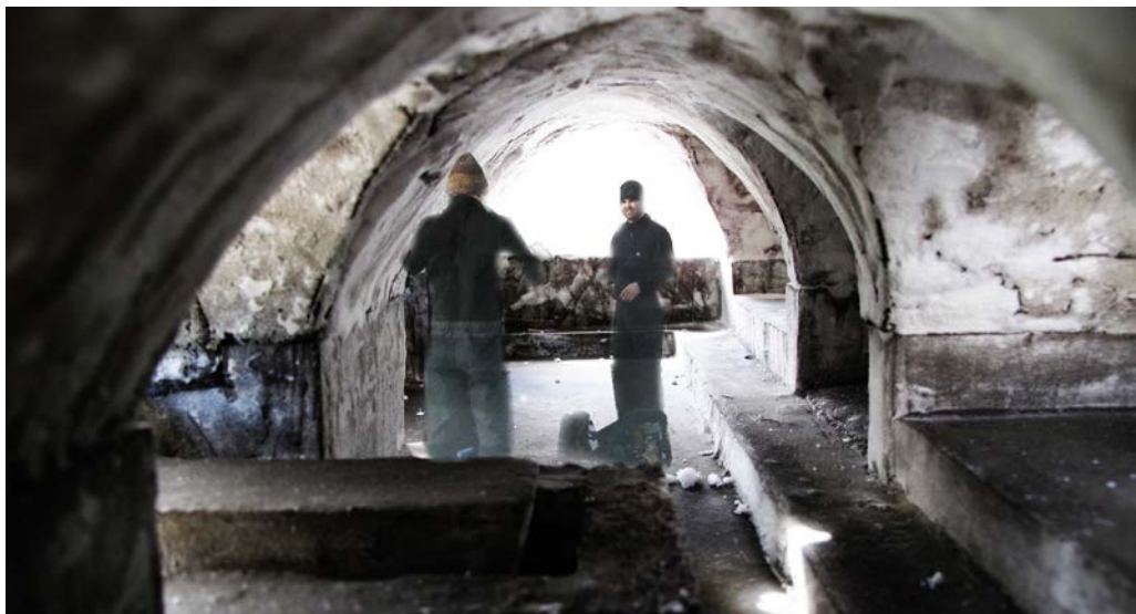
Interiørbilde innvendig oppholdsrom. Bilde viser forskalingens tydelige spor og stemning
